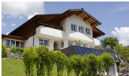
*Thermische Solaranlage in der Brüstung integriert*
