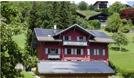
*Photovoltaikanlage in der Dachfläche integriert*
